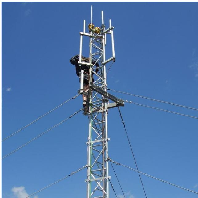
Los cordones para mástiles arriostrados, se producen en formaciones de 7, 19 y 37 alambres generalmente. El rango de resistencia recomendado es 140/160 kg/mm<sup>2</sup>. Todos los alambres están galvanizados en caliente y son del tipo pesado. Pueden suministrarse en bobinas de madera o rollos fraccionados a medida para los distintos niveles. Esto facilita la logística y agiliza el montaje, evitando tener que medir y cortar en obra.
